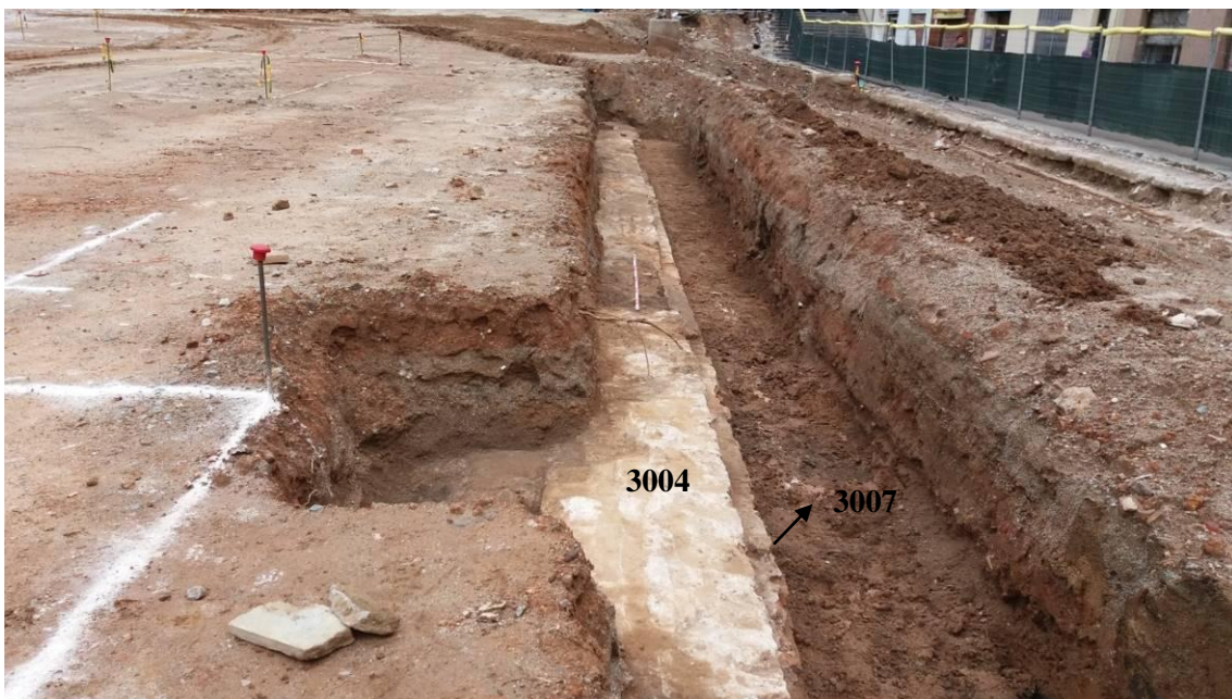
Vista general de la fonamentació 3004 i de la banquetta de fonamentació 3007
