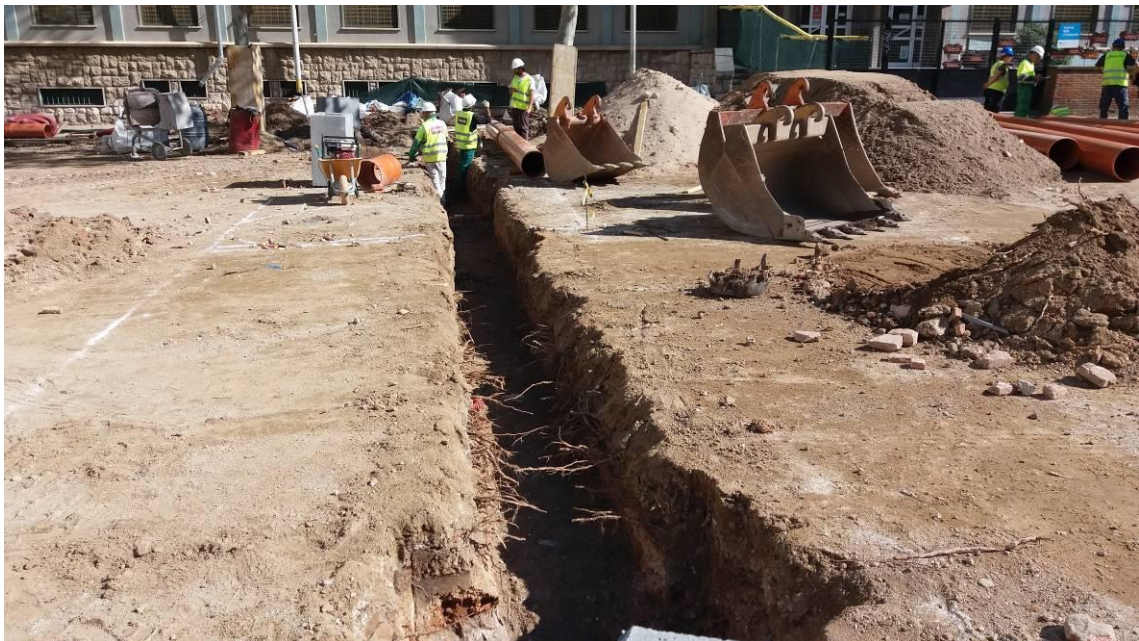
Vista general de la Rasa 5000
