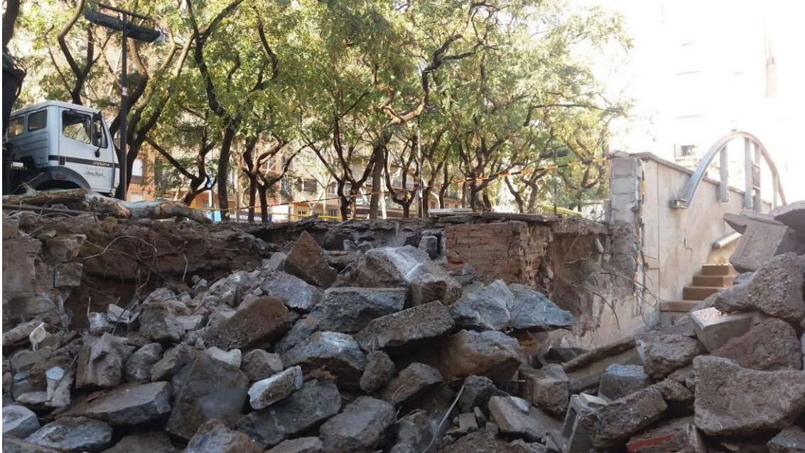
Vista general de l'enderrocament de les escales i font
