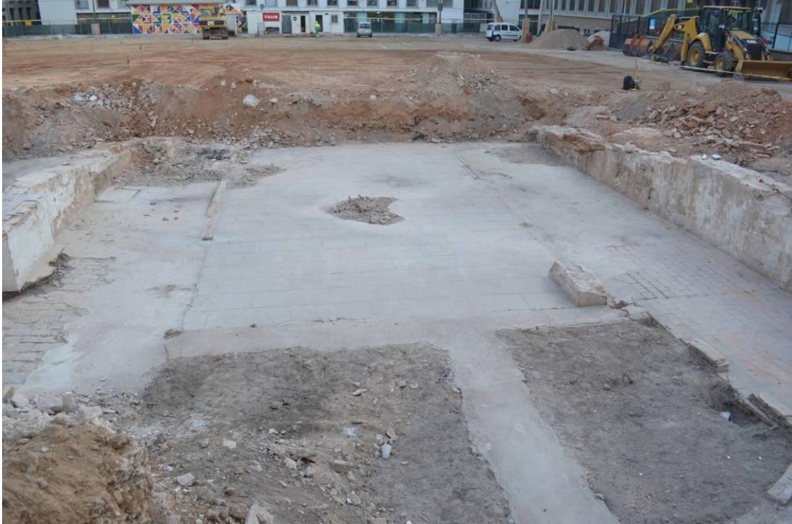
Detall del paviment de maons UE 1009
