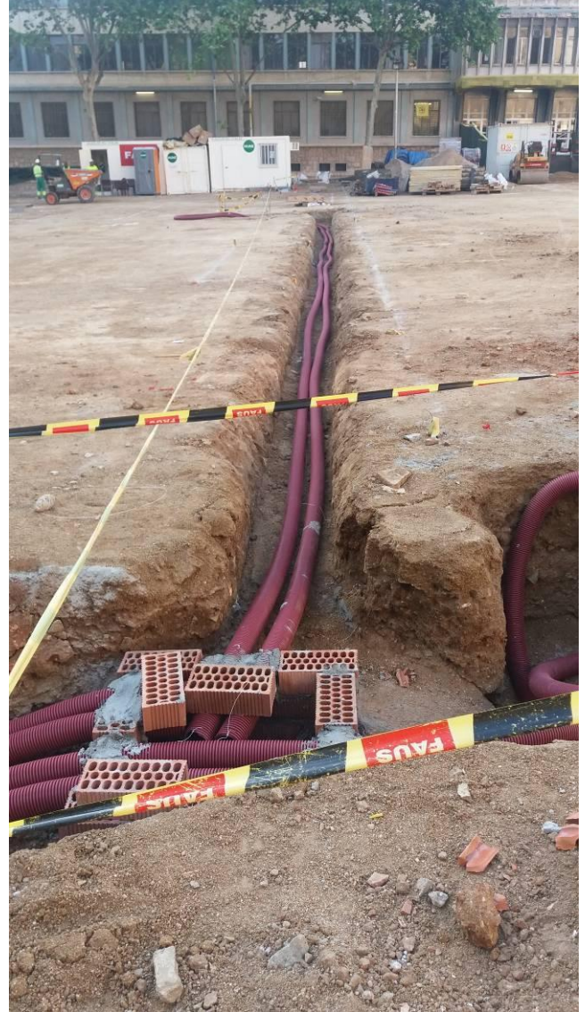
Detall d'algunes de les rases efectuades per a col·locar el cablejat elèctric i els tubs de reg automàtic
