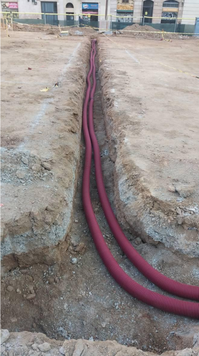
Detall d'algunes de les rases efectuades per a col·locar el cablejat elèctric i els tubs de reg automàtic
