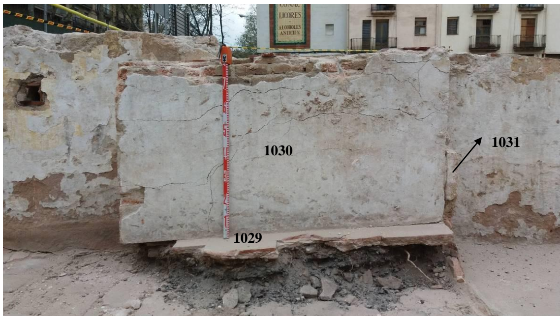
Detall de l'estructura 1030 i del petit envà 1031
